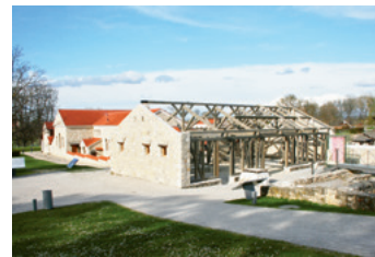
Baufortschritt Haus I © RSC Römerstadt Carnuntum
